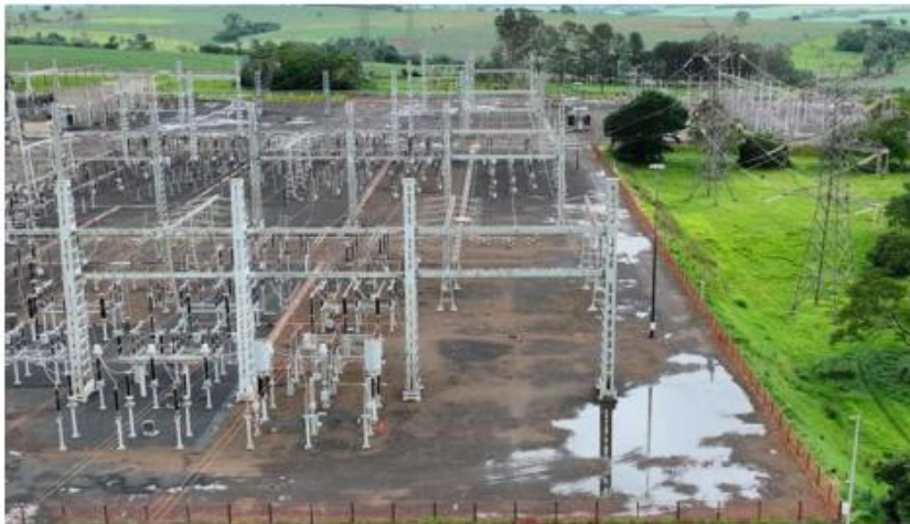
Figura 1: espaço disponível para engate de uma nova linha 230kV na SE Assis.
